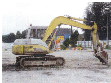
建築地盤挖土機
