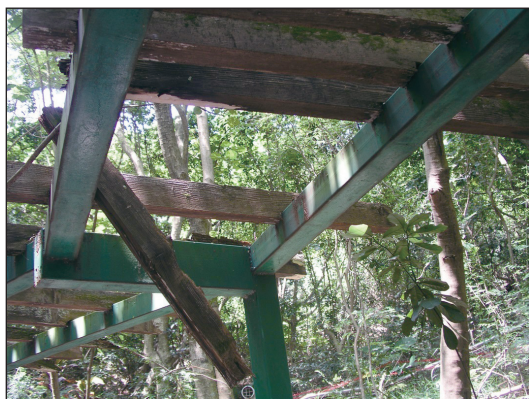
損毀的簷篷並未維修
