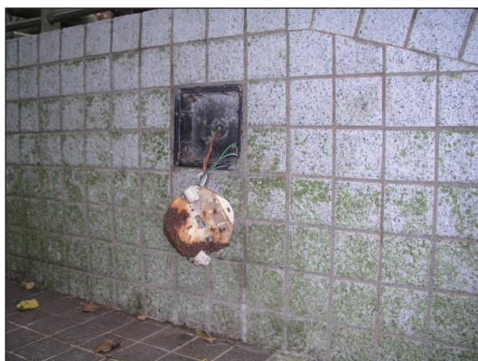
破爛的電線槽蓋並未修理
