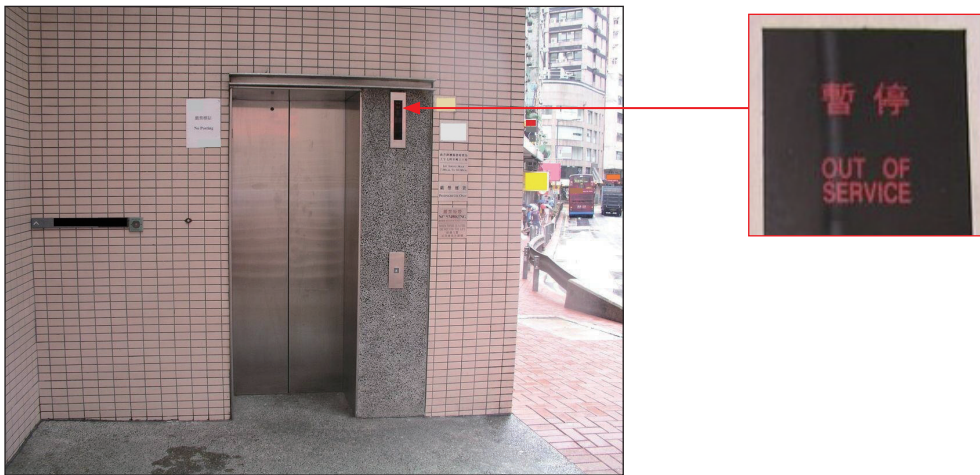
設於主要道路上通往“公眾休憩空間 7”的載客升降機 (二零一四年六月)
