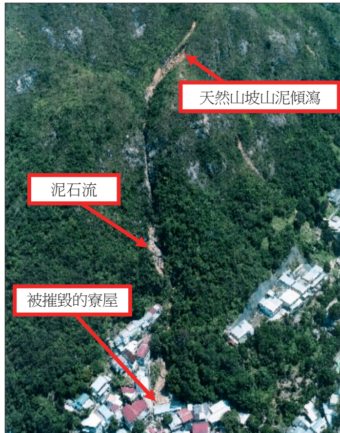
荃灣深井的寮屋被天然山坡山泥傾瀉摧毀 (1999 年 8 月 23 日)
