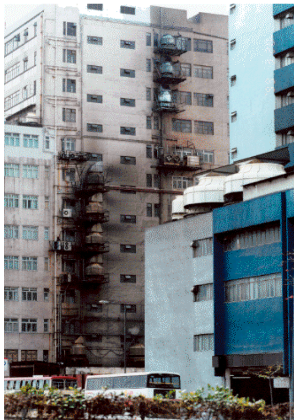
照片六 不同大小的冷卻塔 設置在觀塘的工業大廈 (參閱第 6.28 段)
