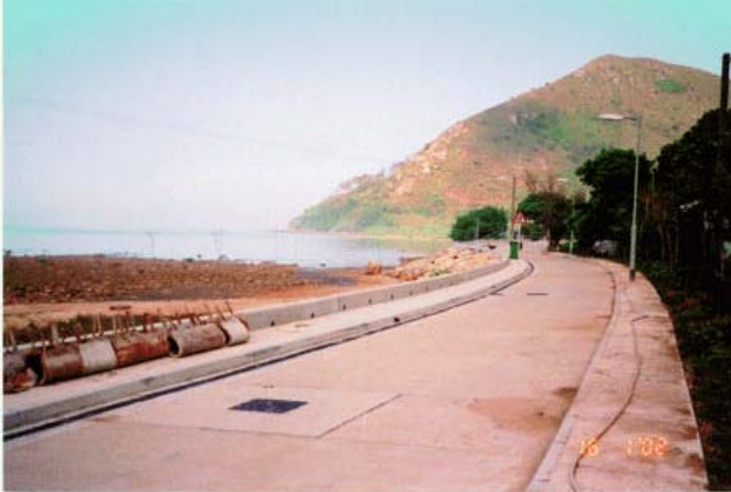
照片一 連接大嶼山深屈與深石村通路的一部分 (參閱第 4.16 段)
