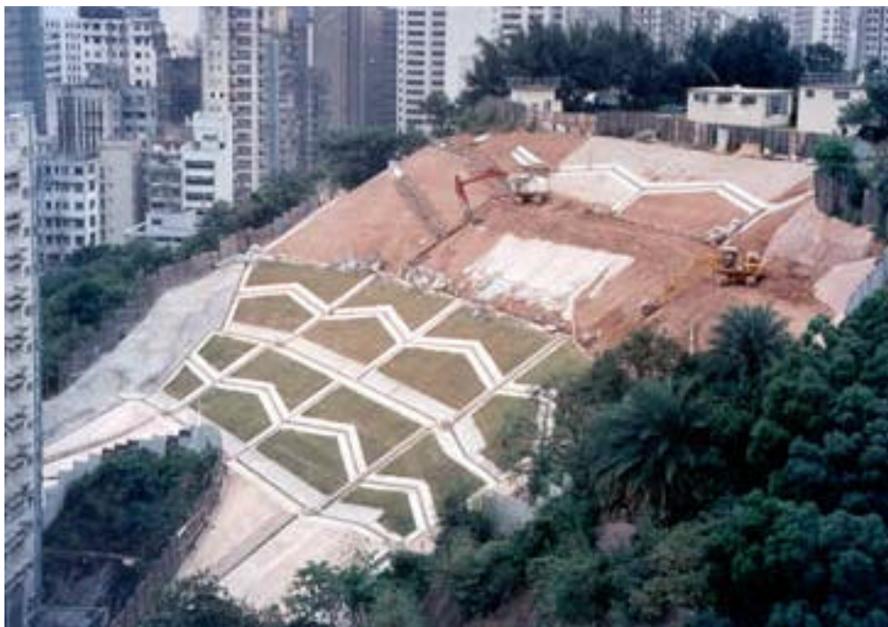
照片二 進行中的斜坡鞏固工程 (參閱第 1.5 段)
