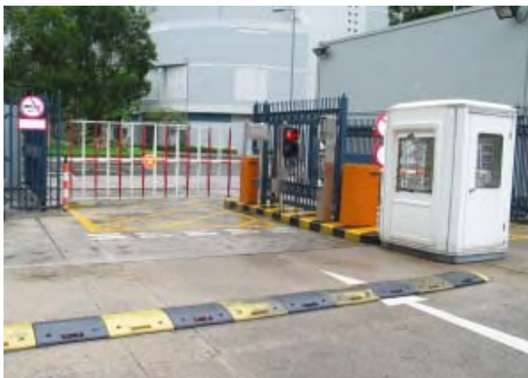
大埔警署的自動車輛柵閘
