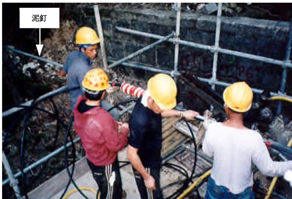
泥釘安裝工程示例
