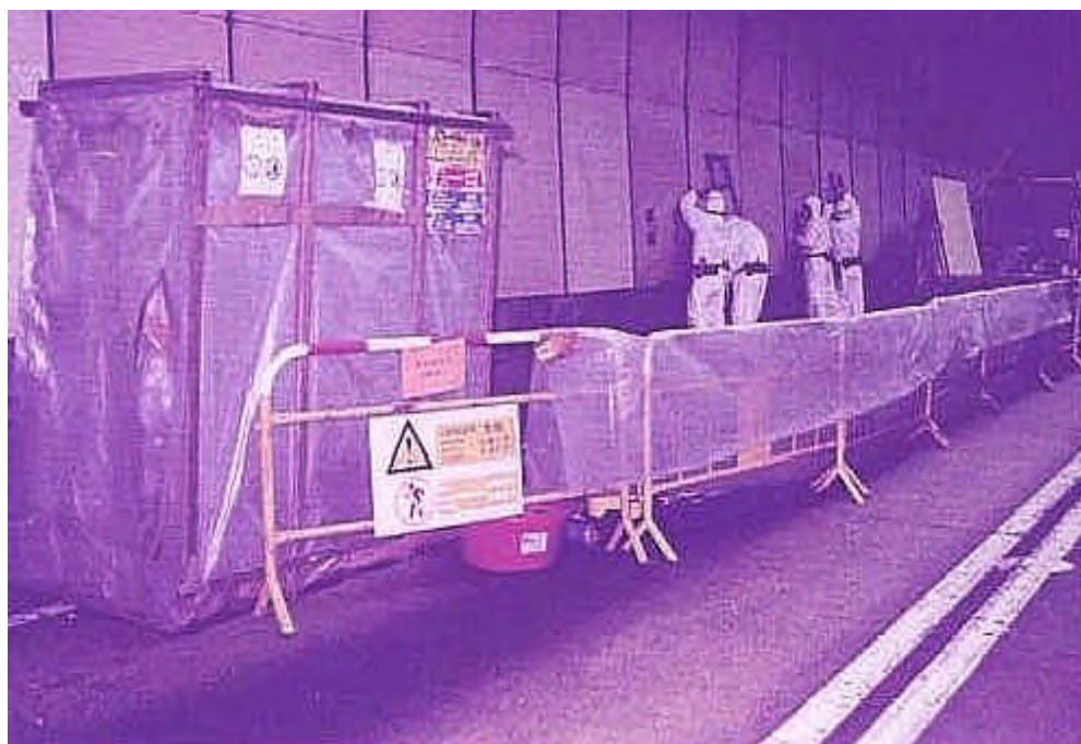
香港仔隧道的牆板更換工程
