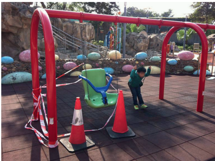
公園內損壞的遊樂場設施有待維修
