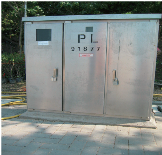
(b) 路旁公共照明控制箱
