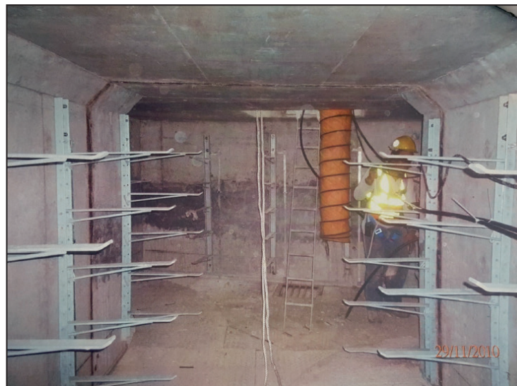
在春坎角興建的試驗性公用設施共同溝 (2006 年)
