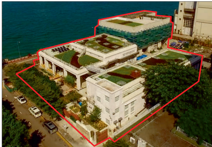
中環基本污水處理廠
