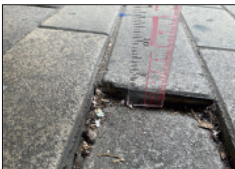
(e) 城南道的鋪路磚高低不平差距逾 10 毫米
