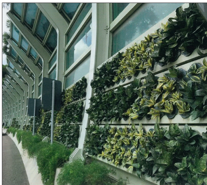
屯門公路東路段隔音屏障上的垂直綠化板
