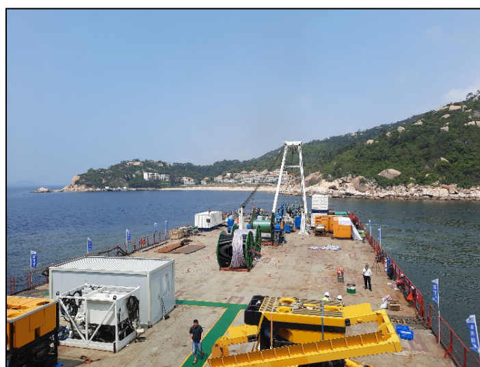
鋪設海底光纖電纜
