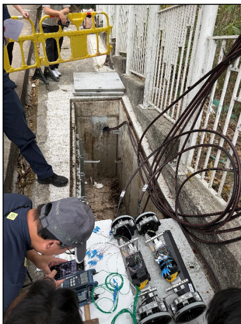
鋪設光纖連接線路
