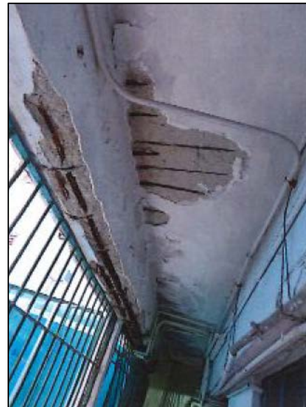
(d) Spalling of concrete in corridor
