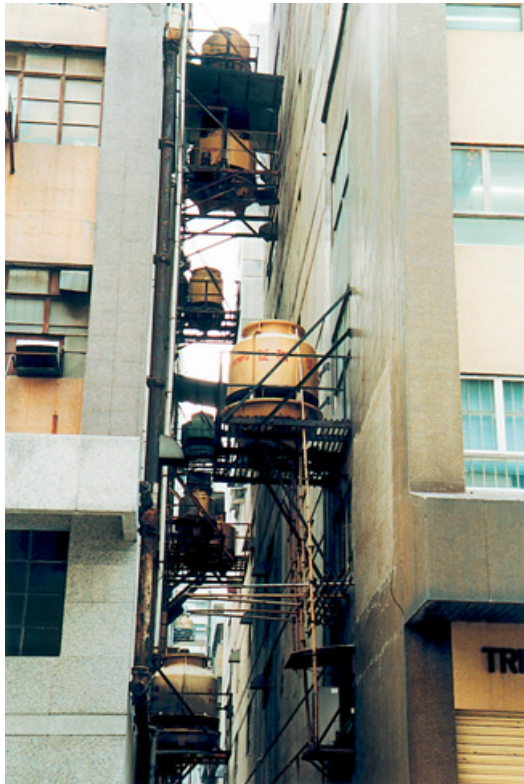
照片五 发现冷却塔设在观塘 两幢工业大厦之间的后巷里 (参阅第6.28 段)
