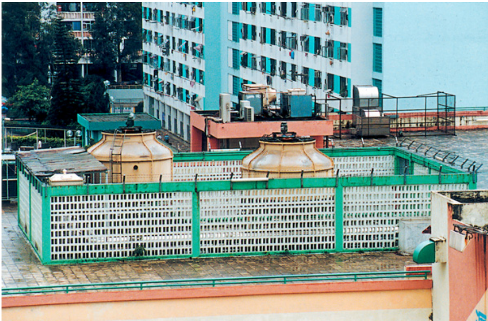
照片四 两座巨大的冷却塔设置在沙田一公共屋邨的平台上 (参阅第6.28 段)
