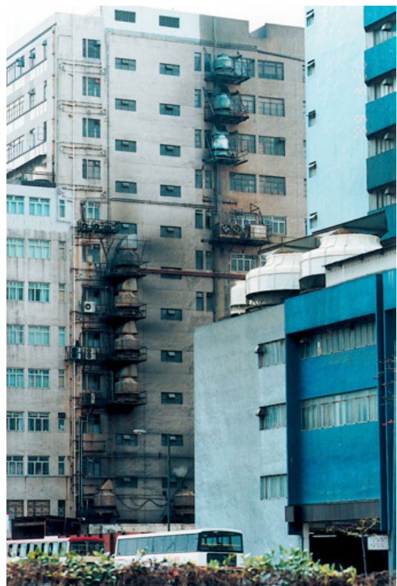
照片六 不同大小的冷却塔 设置在观塘的工业大厦 (参阅第6.28 段)
