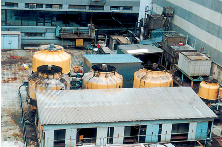
照片三 新旧冷却塔设置在旺角一幢商业大厦的平台上 (参阅第6.28 段)
