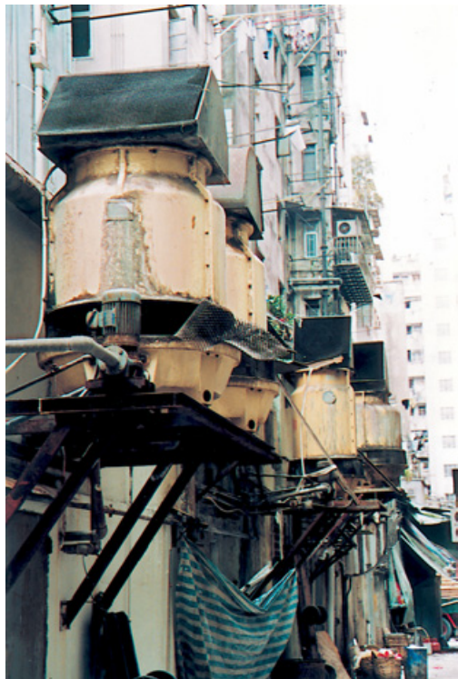
照片一 一堆破旧的冷却塔 设置在旺角一条后巷里 (参阅第 6.28 段)
