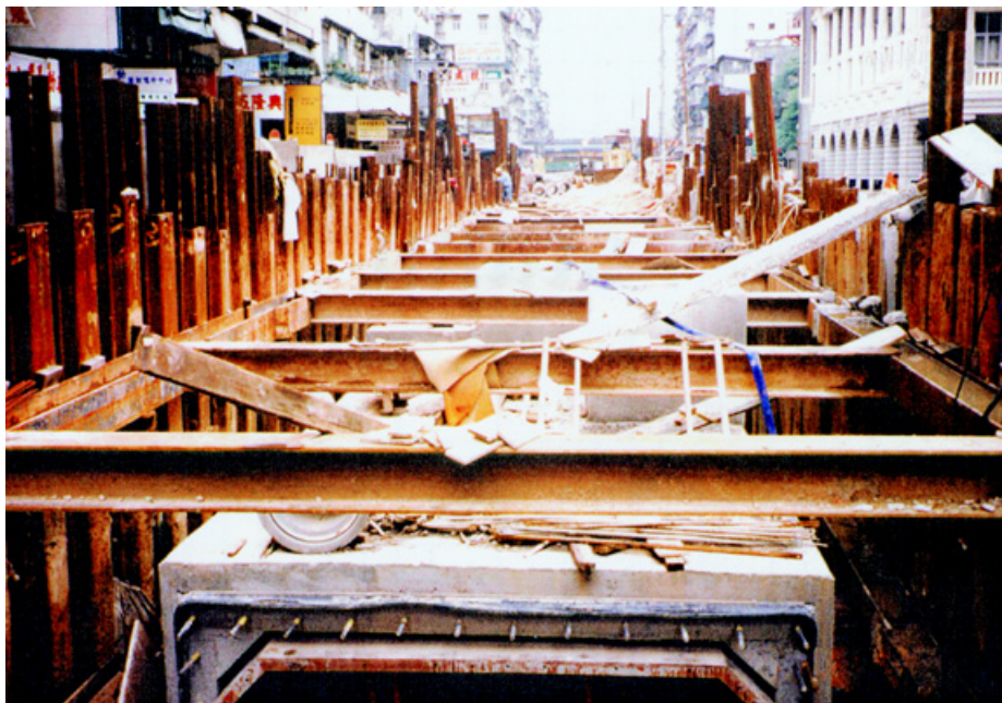
敷设中的钦州街箱形暗渠
