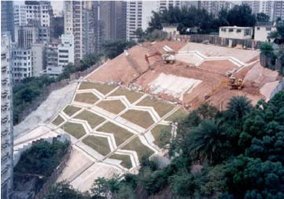
照片二 进行中的斜坡巩固工程 (参阅第1.5 段)
