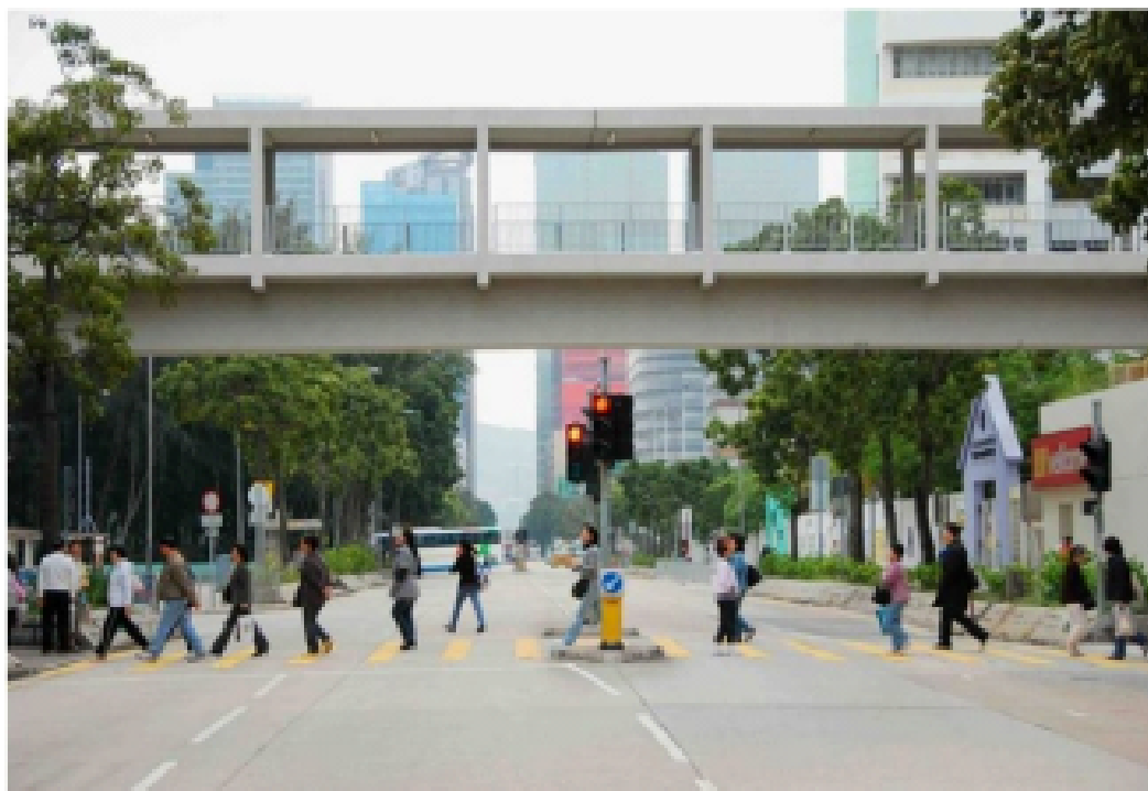
九龍灣啟業邨附近橫跨宏照道的行人天橋
