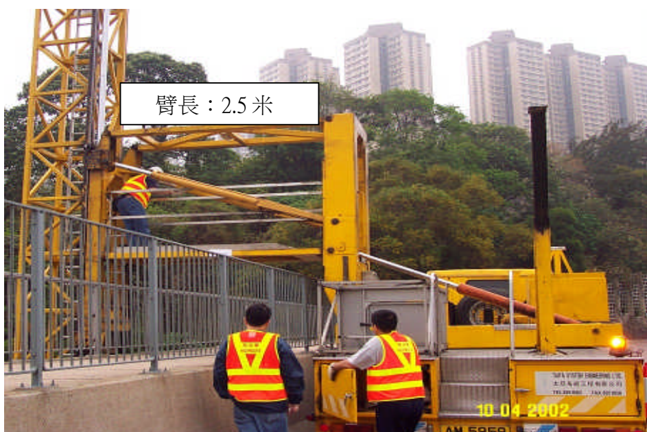
路政署用以檢查鴨脷洲大橋的橋底檢查設備
